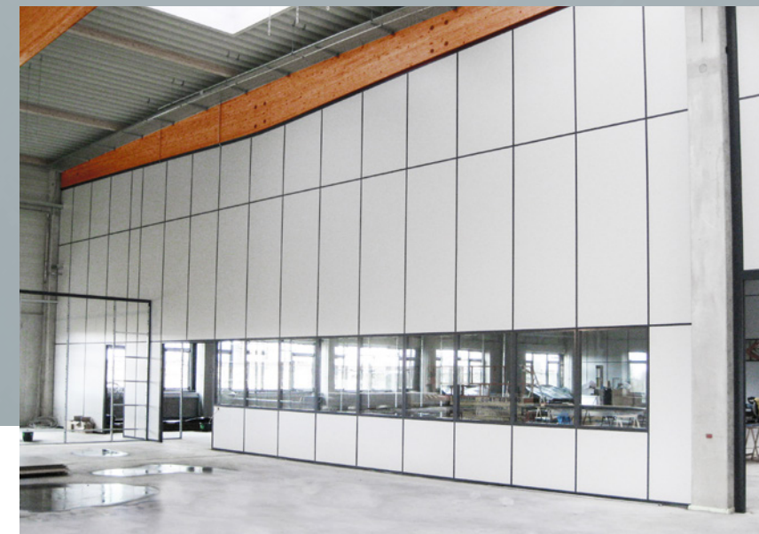
Das flexible Bausystem ermöglicht auch die Aufnahme größerer Deckendurchbiegungen. Die Anbindung direkt unter dem Hallendach ist damit immer gewährleistet.
